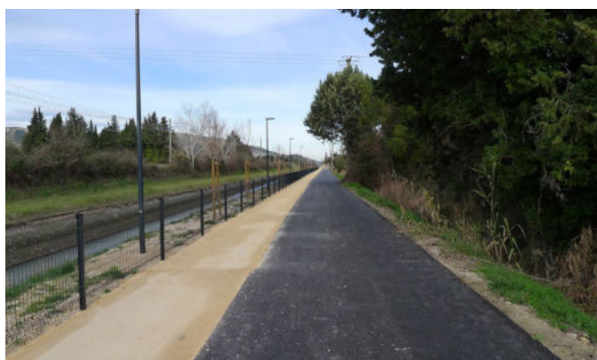
le chemin de promenade le long du canal, vue au Nord
