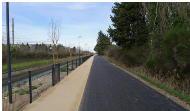
le chemin de promenade le long du canal, vue au Nord
