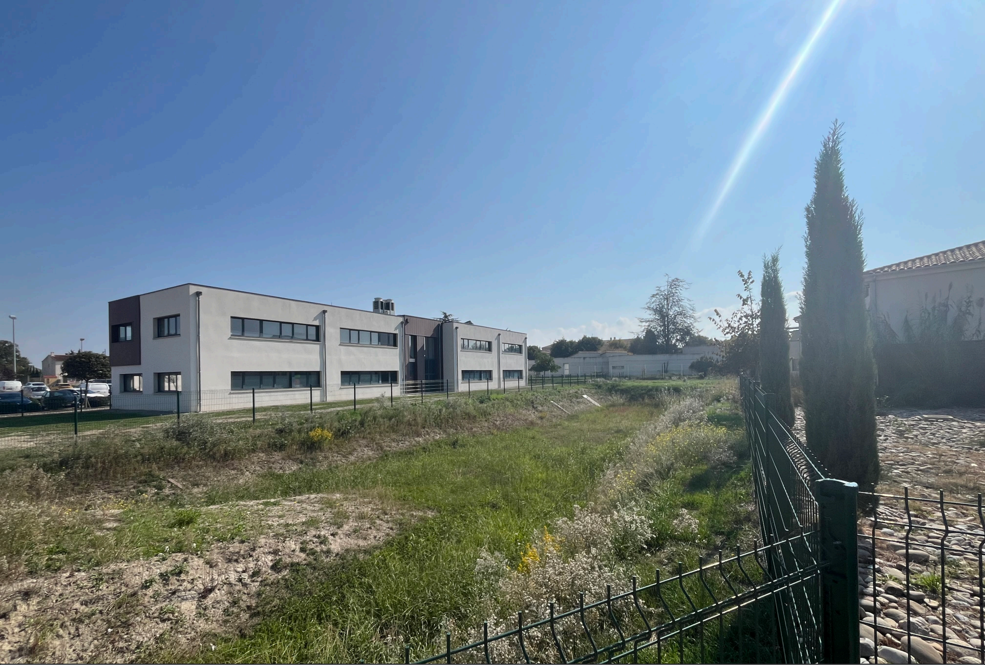
Bassin de rétention des Eaux Pluviales
