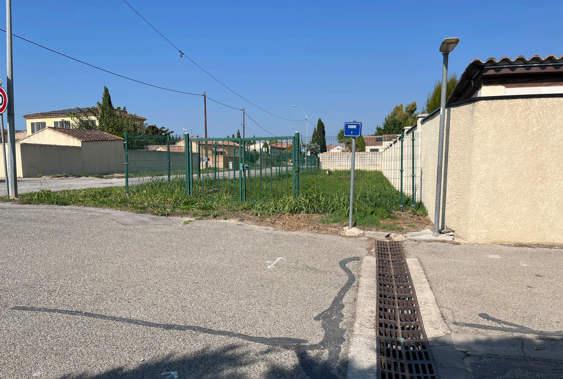
Bassin de rétention des Eaux Pluviales
